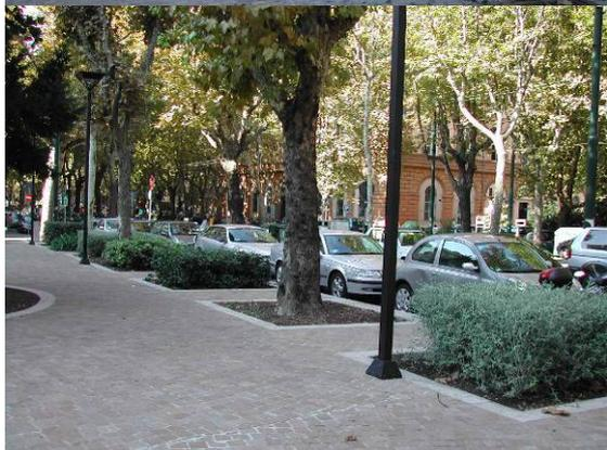
L'INSIEME SISTEMATICO DELLE OPERE HA RIGUARDATO: LA CREAZIONE DI UN NUOVO DISEGNO DELLE AIUOLE CON AMPI SPAZI DI FORMA LIBERA INTORNO ALLE ALBERATURE ESISTENTI, LA COLLOCAZIONE DI PANCHINE LUNGO IL PERIMETRO, LA REALIZZAZIONE DI PAVIMENTAZIONE IN CUBETTI DI PIETRA FORTE A CERCHI CONCENTRICI, LA SOSTITUZIONE DEL VECCHIO IMPIANTO DI ILLUMINAZIONE PUBBLICA INTEGRATI CON PROIETTORI SULEL FACCIATE, NUOVO IMPIANTO DI IRRIGAZIONE, IL COMPLETO RIFACIMENTO DELLA RETE DI SMALTIMENTO ACQUE METEORICHE.
